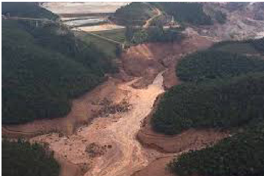
Figura 3.7 - Barragem de Fundão, em Mariana (MG), após o processo de liquefação.
