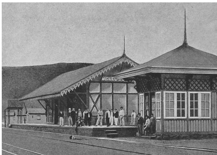
Figura 33 – Estação Ferroviária de Miguel Burnier
