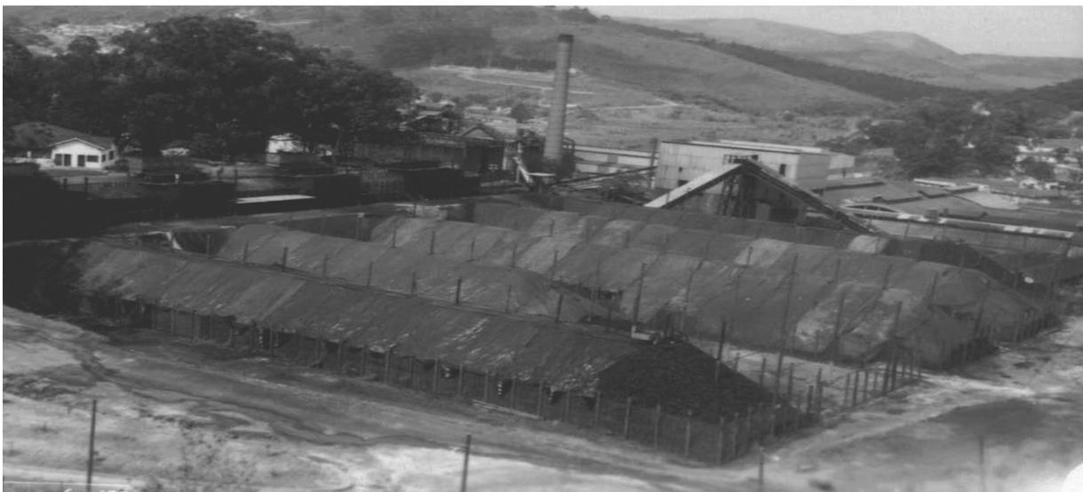
**FIGURA 7.2 –8** - Pátio de carvão na Usina Gorceix, em 1980.Capacidade para 32.000MDC de carvão, proporcionando uma autonomia de até 4 meses de operação da usina.A recepção era dotada de meios eletrônicos de cubagem das carretas e era capaz da descarga de 100 MDC por hora.
