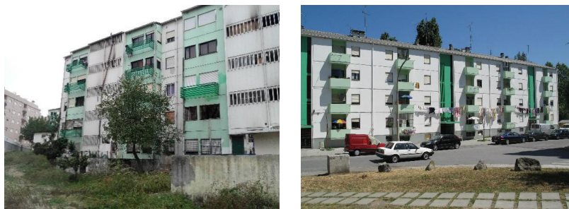
Figura 3 – Imagens dos edifícios do Bairro Social de Santa Tecla.
